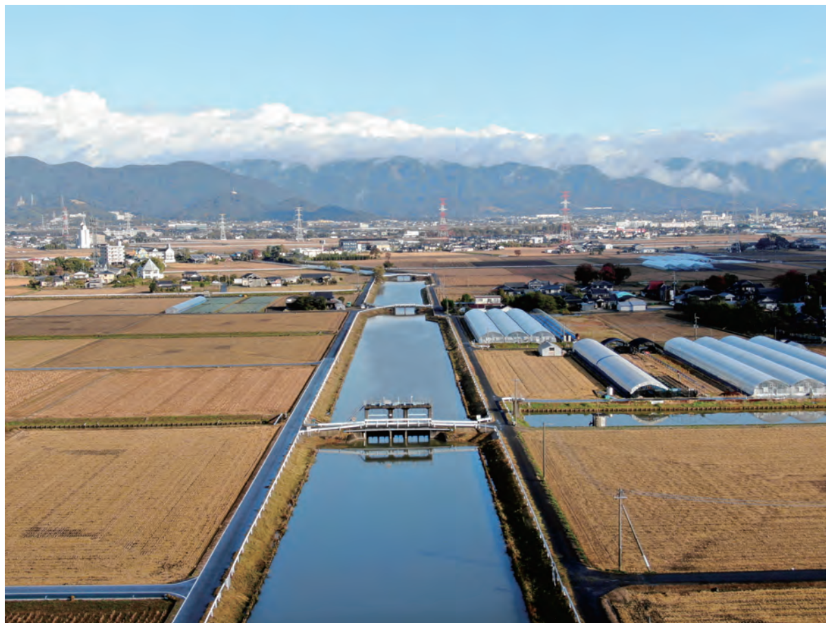
幹線水路 大詫間線 上流を望む 【神崎市 千代田地区】
